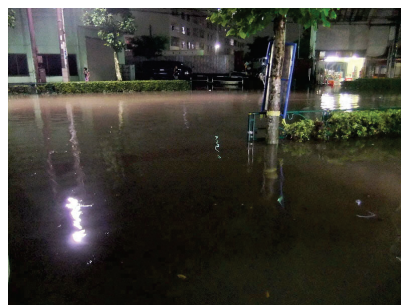
明治通りが冠水(北区堀船)
