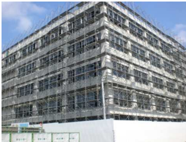
建物周囲に足場を設置
