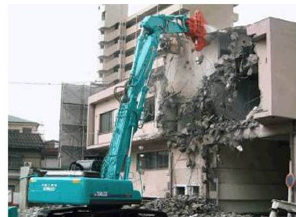
圧砕機による解体作業
