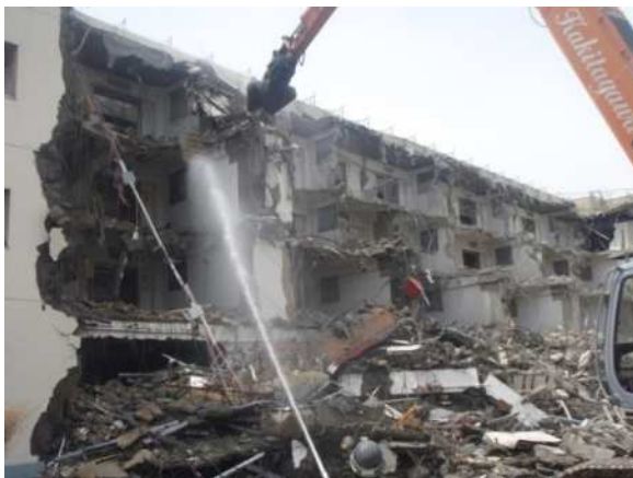
散水しながらの解体作業
