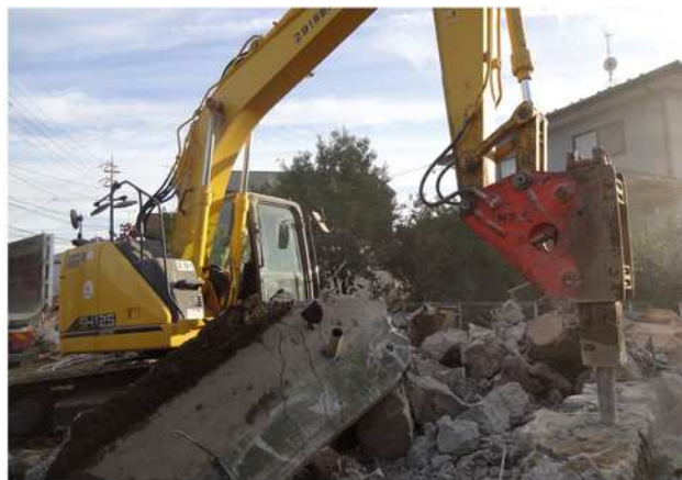
ブレーカー(破碎機)による 解体作業
