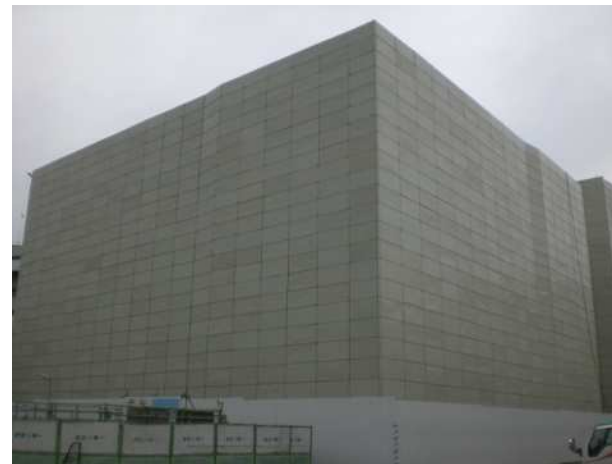
防音パネル張り
