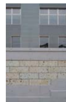
大谷石再利用よう壁 即ちよう造りかみを骨体し、新しいよう壁の仕上に大谷石を再利用しました。
