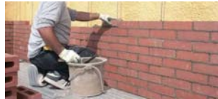
外壁中空レンガ積み(施工写真) 外壁仕上げは外断熱を基本としました。開口部は後述エコガラスで断熱性能を確保しています。
