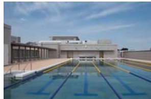
プール 4F 遮熱シート貼で快適なプールサイドを備えた25mプールです。災害時の消防用水、マンホールトイレ排水にも活用します。
