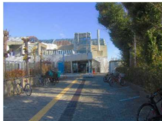
⑧体育館プール棟エントランス
