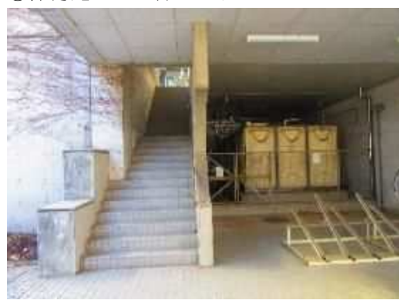
⑩体育館プール棟階段（2/2）
