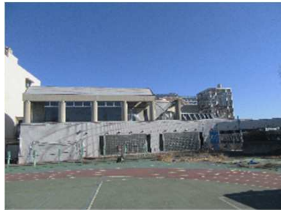
⑥体育館プール棟全景（2/2）
