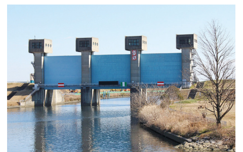
岩淵水門(青水門)
