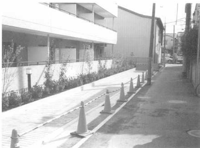
道路との段差を小さくした歩道(シルバーピアすずらん)
