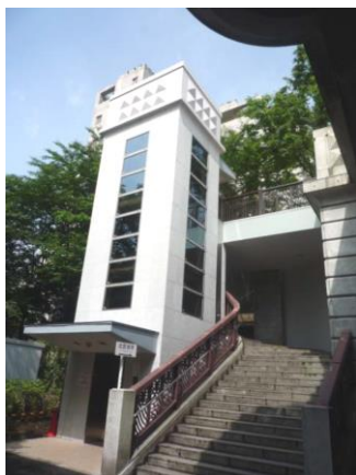
音無橋脇昇降施設（エレベーター）
