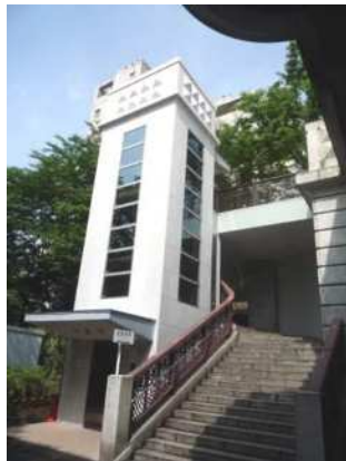
音無橋脇昇降施設（エレベーター）
