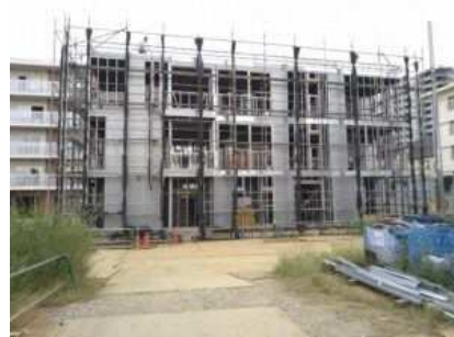
写真：建設中のグループホーム
