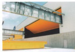
大型跳上げ扉（鋼材倉庫内扉開口）
