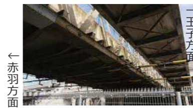
桁裏（右は後に新設された人道橋）
