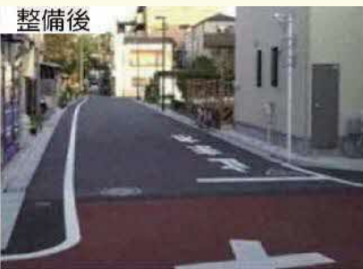
整備後 主要生活道路の整備例（道路拡幅）
