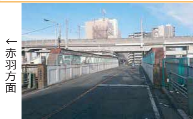
現在の十条跨線橋
