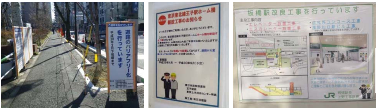
図 8-3 工事現場におけるPRの事例
