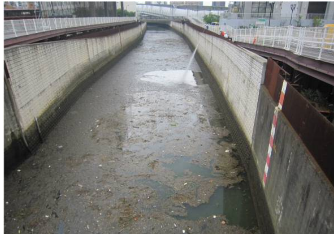
高圧放水による浮遊物の沈降作業の状況
