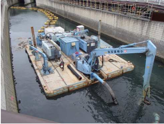
堆積土を引き上げる状況
