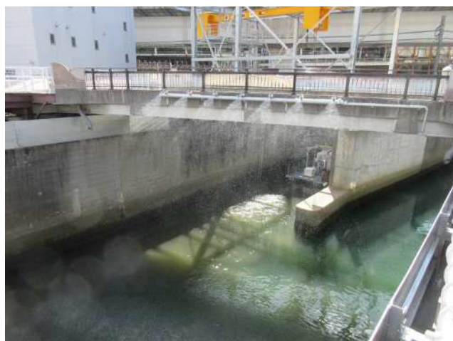
散水状況(王子桜橋下流)
