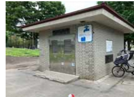
給水ステーション
