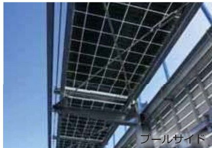
体育館棟屋上
