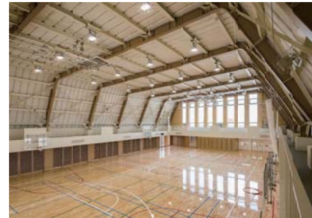
体育館 大きな窓を設けた明るい体育館です。空調を完備しており、教育環境の向上を図ります。災害時は、地域の避難所として利用できます。
