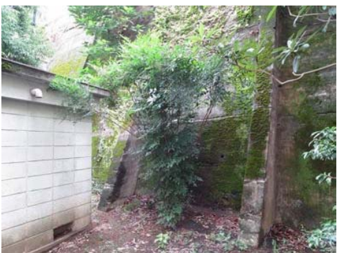
⑪北側擁壁
