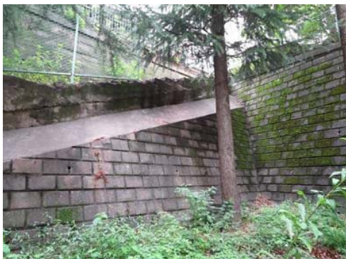
⑨北東側擁壁
