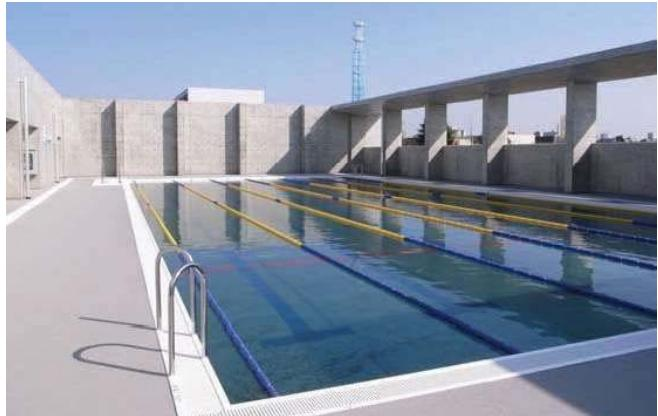
**+ プール** 日射を遮るために庇を設置しています。プールの水は災害時の消防水利、マンホールトイレ用水として利用します。
