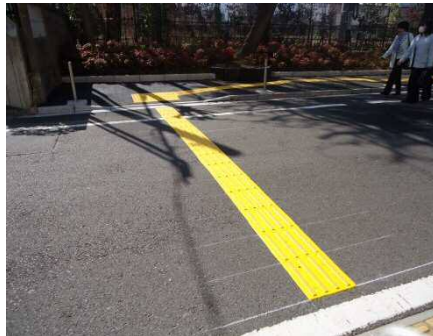
点字ブロック
