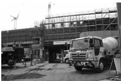
王子小学校・王子中学校建設工事現場
