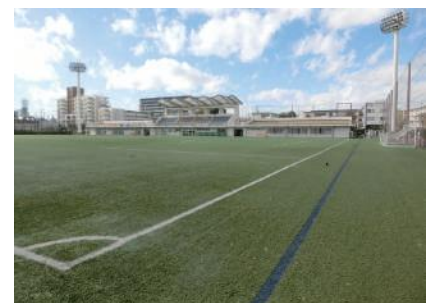
現在改修中の「赤羽スポーツの森公園競技場」
