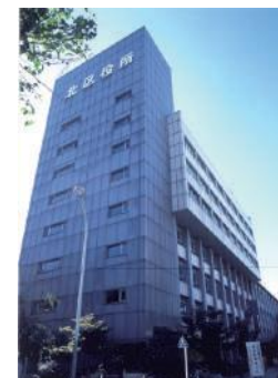
建替えが計画されている北区役所現庁舎
