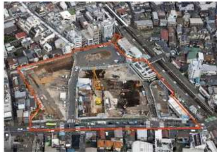
令和3年3月末（解体完了後）
