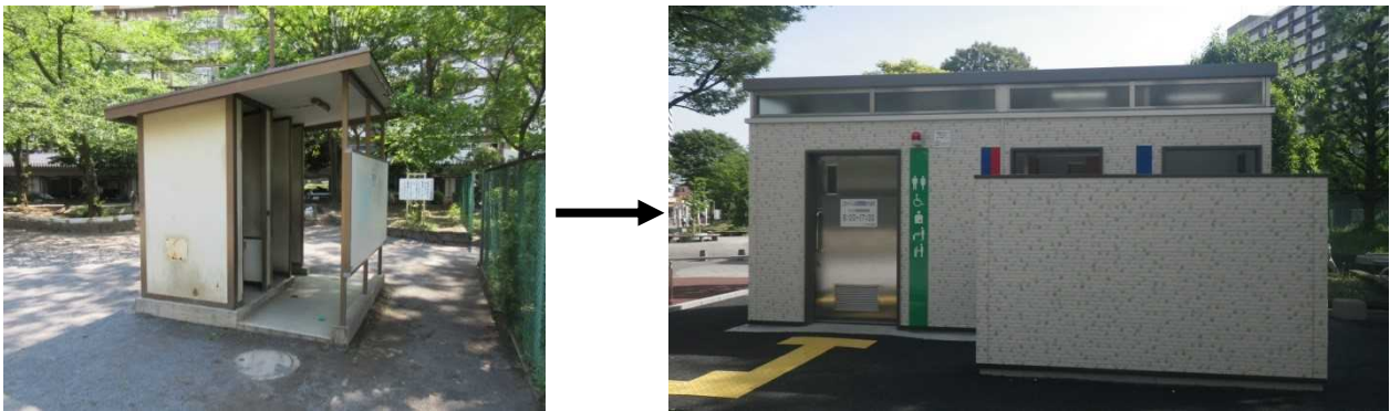
公園施設（トイレ）の更新およびバリアフリー化を行った事例（王子五丁目児童遊園）
