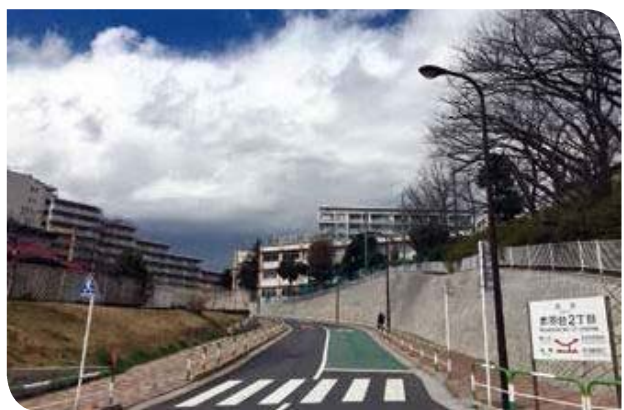
幹線区道拡幅（赤羽台）
