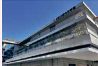
いずれも南校舎外観
