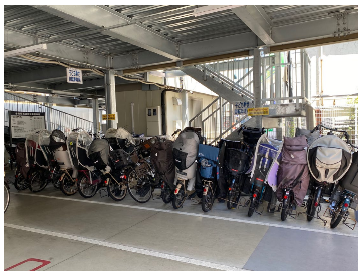
図 4-18 大型子乗せ自転車に対応した平置きの駐車スペース （十条駅西口自転車駐車場）
