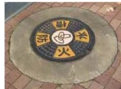
防火水槽の設置
