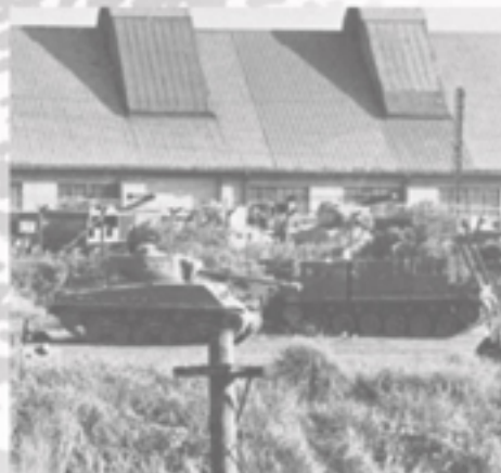
戦車修理工場として使用された赤羽南5丁目のTOD第2地区(放送記録氏撮影)
