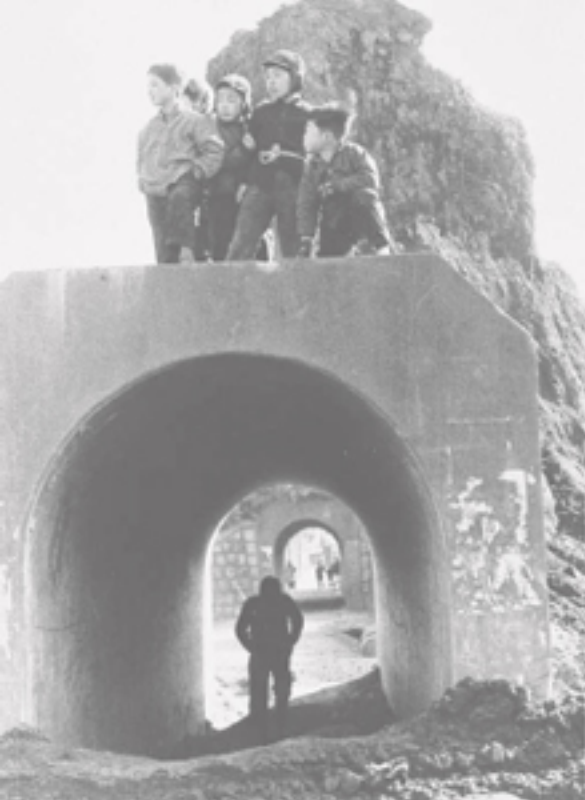
切り崩された火薬庫の筒山 (故渡辺肇氏撮影)
