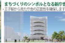
図4 王子駅から見た庁舎の正面性を確保します。
