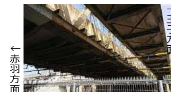
桁裏（右は後に新設された人道橋）
