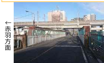
現在の十条跨線橋
