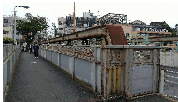
鉄道橋を再利用したトラス
