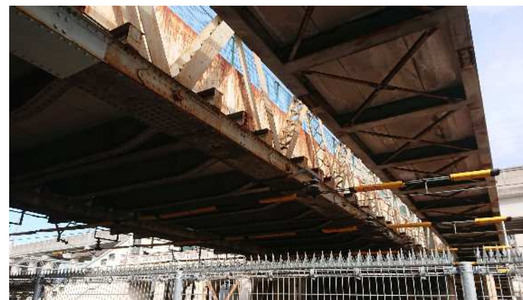
桁裏（右は後に新設された人道橋）
