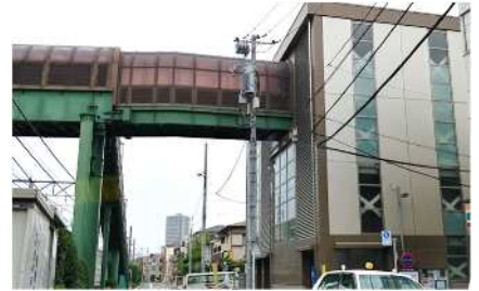
車坂跨線人道橋エレベーター
