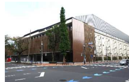
ナショナルトレーニングセンター拡充棟
