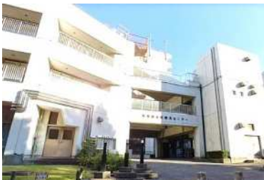
防災センター
