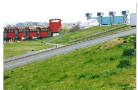
新旧岩淵水門（青水門・赤水門）
