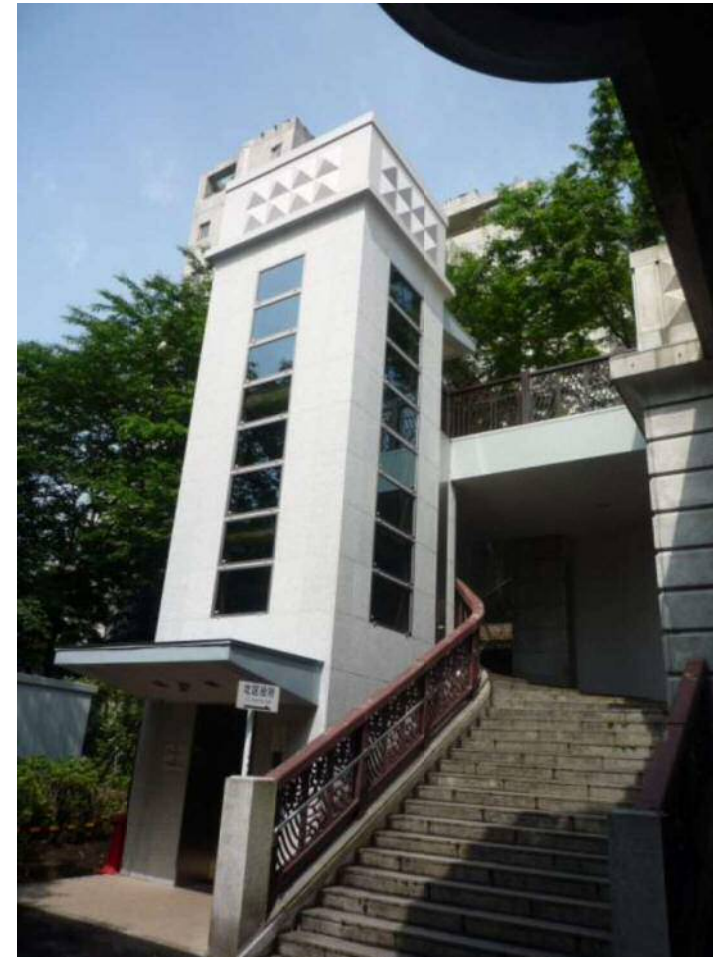
階段とエレベーター建屋
